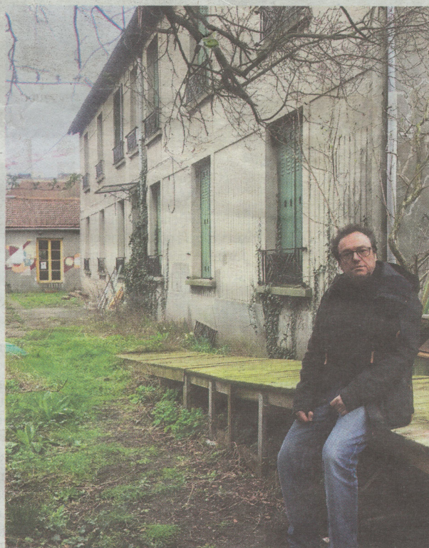
Romainville, le 27 février. Bruno Athea veut bâtir un bâtiment en bois à la place de ces constructions vétustes.
